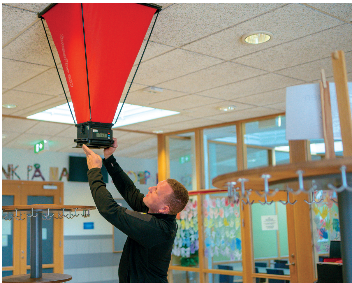
Luftflödesmätning på Fridtunaskolan
